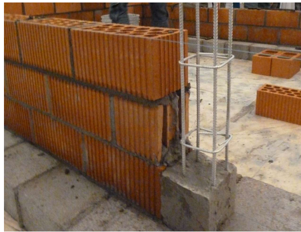
AB serklaž sa prefabrikovanom armaturom – Meksiko
