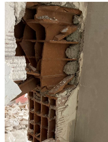
Ošupljeni modularni blokovi sa horizontalnim šupljinama
