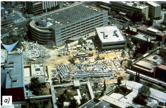
Slika 7 – Srušene zgrade bolnica u Meksiko Sijtu nakon Michoacán zemljotresa (EERI, 1985): a) opšta bolnica, b) i porodiljsko odeljenje bolnice Juarez
