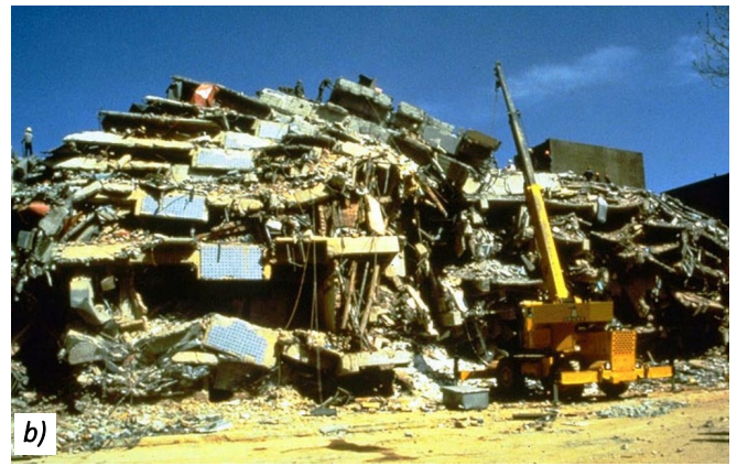
Slika 7 – Srušene zgrade bolnica u Meksiko Sijtu nakon Michoacán zemljotresa (EERI, 1985): a) opšta bolnica, b) i porodiljsko odeljenje bolnice Juarez
