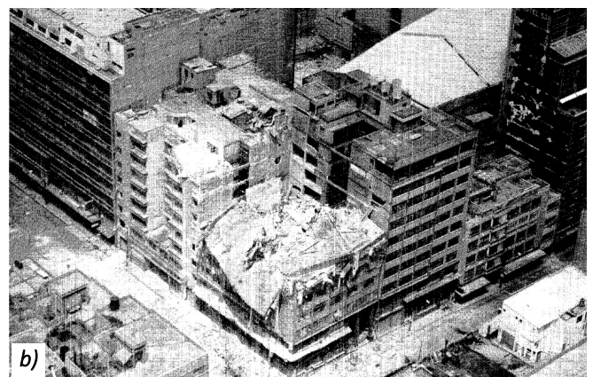
Slika 6 – Uticaj zidane ispunjene na ponašanje ramovskih konstrukcija u Michoacán zemljotresu: a) zgrada sa malim oštećenjima konstrukcije (EERI, 1985), i b) srušena zgrada usled rotacije i sudaranja sa susednim objektima (NBS, 1987)
