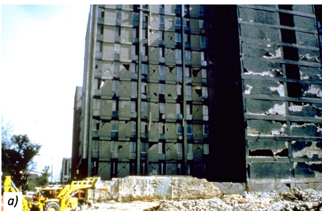
Slika 6 – Uticaj zidane ispunjene na ponašanje ramovskih konstrukcija u Michoacán zemljotresu: a) zgrada sa malim oštećenjima konstrukcije (EERI, 1985), i b) srušena zgrada usled rotacije i sudaranja sa susednim objektima (NBS, 1987)
