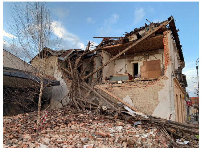
Oštećeni zidani objekti u Petrinji, Hrvatska nakon zemljotresa magnitude 6.4 od 29.12.2020 (izvor: Damir Lazarević)
