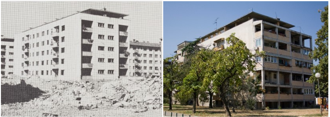
Slika 2 – Dogradnja zgrade oštećene zemljotresom
