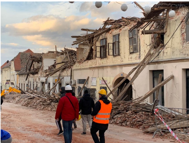
Oštećeni zidani objekti u Petrinji, Hrvatska nakon zemljotresa magnitude 6.4 od 29.12.2020 (izvor: Damir Lazarević)
