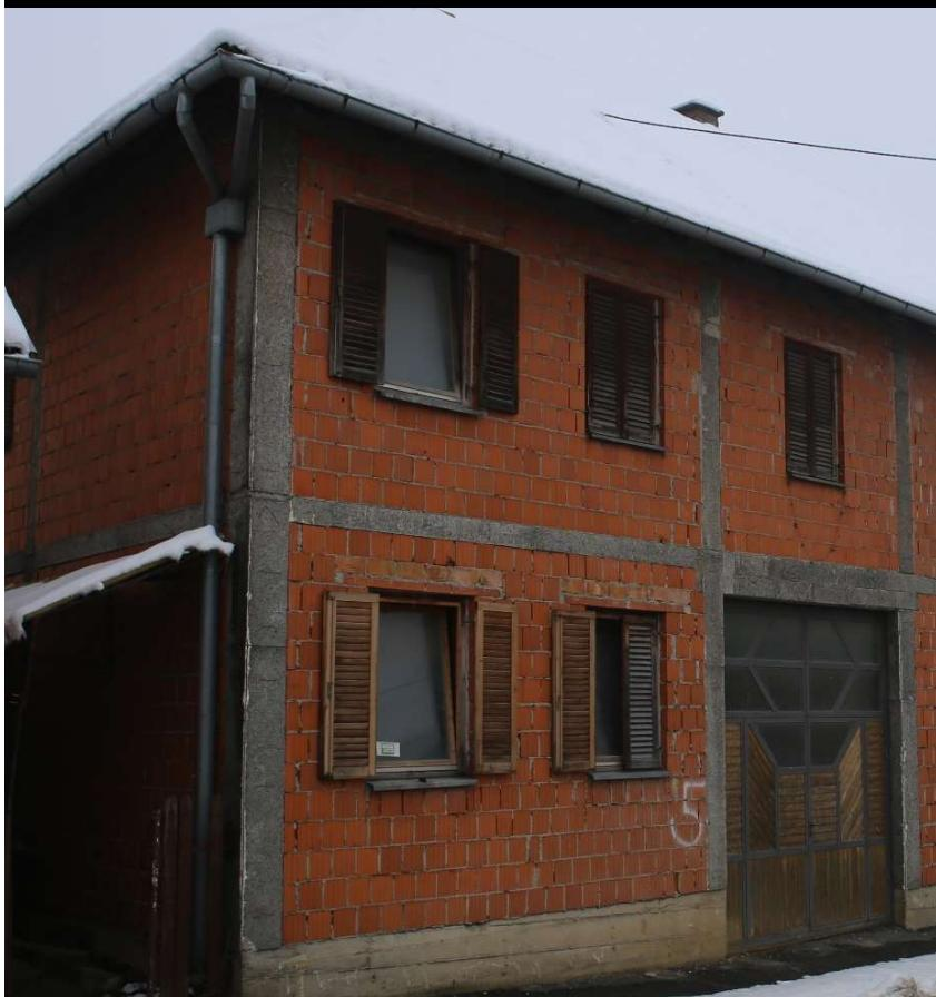
Pravilno projektovane i izvedene konstrukcije ovog tipa pretrpele su ili neznatna oštećenja ili su ostale neoštećene u nedavnim zemljotresima u regionu, npr. zemljotres u Petrinji od 29.12.2020.
