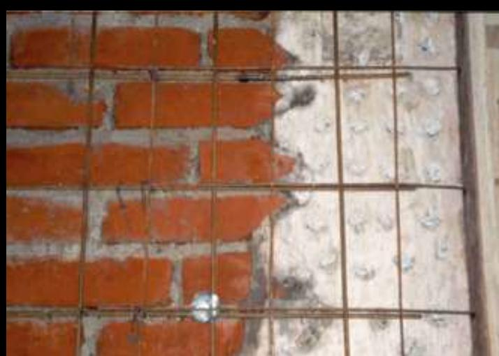
Veoma je važno da se vertikalni AB serklaž tretira kao deo zida, i da se ojača na isti način kao i zid
