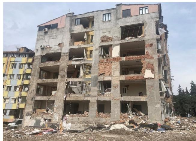
**Slika 4** Lom i ispadanje ispune van ravni u AB zgradama bez konstruktivnog oštećenja (izvor: SUZI-SAEE)
