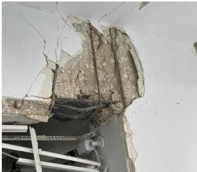
**Slika 6** Izvijanje i lom podužne armature u AB gredama
