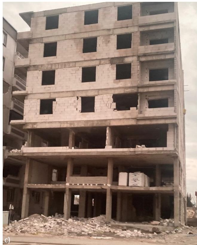
**Slika 16** Oštećenja ispune od šupljih opekarskih blokova (a), AAC (autoklavirani gas beton) blokova (b) i šupljih betonskih blokova (briket)(c) (izvor: SUZI-SAEE)
