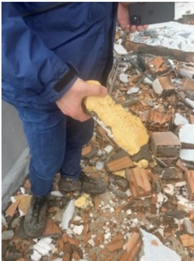
**Slika 14** Oštećenja i kolaps zidane ispune u petoetažnoj zgradi bolnice u Iskenderunu, koji su doveli do neupotrebljivosti bolnice iako zgrada bolnice nije imala velika konstruktivna oštećenja (izvor: SUZI-SAEE)
