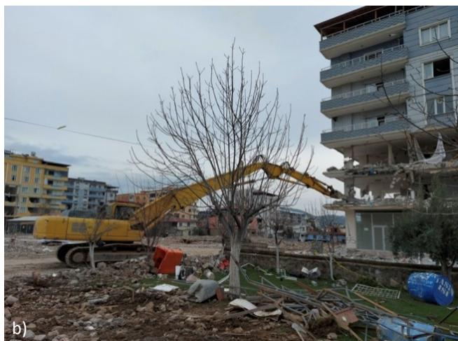
**Slika 20** Uklanjanje teško oštećenih zgrada u martu 2023.: a) kamioni odvoze ostake srušenih zgrada i b) rušenje teško oštećene zgrade u gradu Nurdagi. (izvor: SUZI-SAEE)
