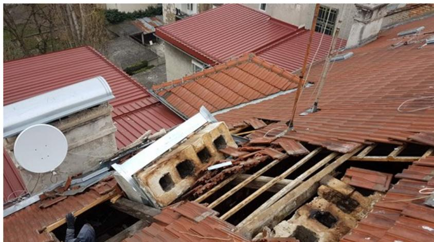
Slika 4 – Oštećenje krovišta uslijed urušavanja dimnjaka (autori fotografija: Volonter Statičar, Karlo Jandrić)
