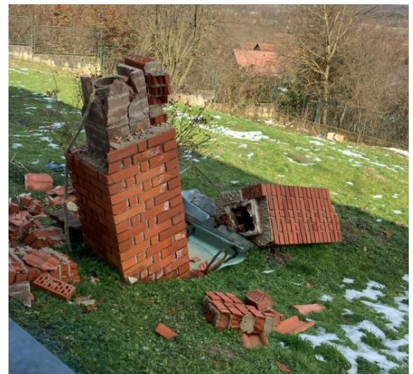
**Slika 7 – Lom i pad dimnjaka (izvor: SUZI-SAEE)**
